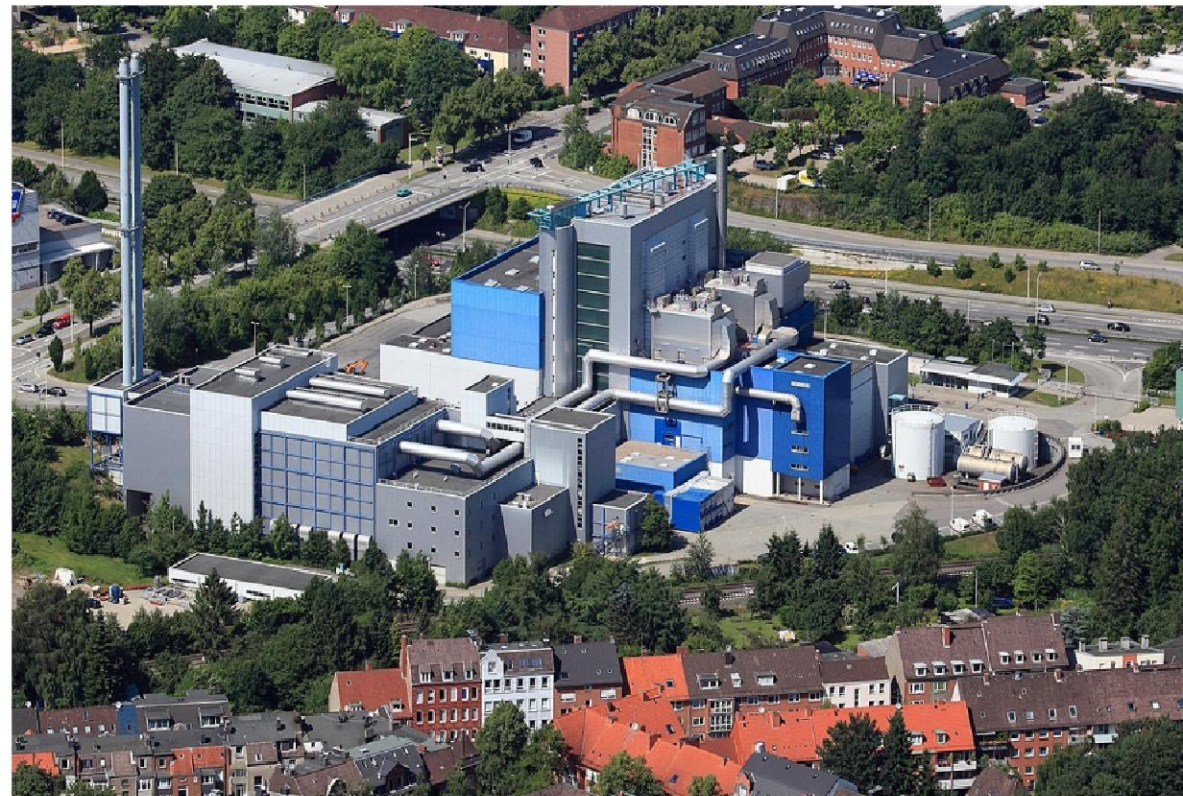
Instalacja w Kolonii (Niemcy)
