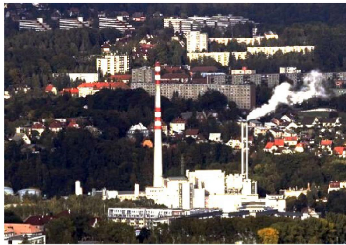
Instalacja w Libercu (Czechy)
