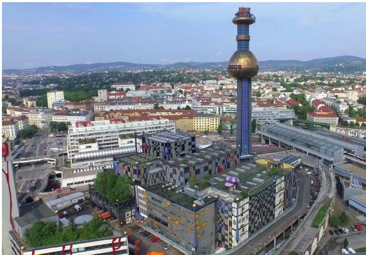
Instalacja w Wiedniu (Austria)
